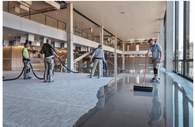
Egaliseren met behulp van pomptechniek, UZIN RR 201 met UZIN NC 170 LevelStar.
