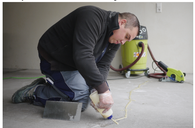
Na het stofvrij maken, plaatsen van ankerkrammen en na het goed schudden van de 2 componenten vullen van de zaagsneden/voegen met UZIN KR 516.
