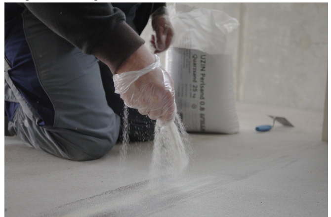
Vlak gestreken UZIN KR 516 vervolgens vol-en-zat afzanden met vuurgedroogd zand 0,3-0,8. Na doorharding overtollig zand verwijderen.
