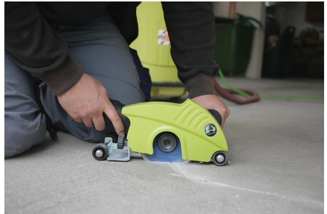
Voegen en/of scheuren verbreden en tevens haaks inslijpen met bijvoorbeeld de dekvloerzaag van Wolff.
